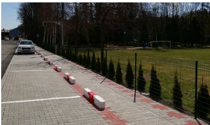
Ukončenie prác na parkovisku - uloženie a nátery vodorovného dopravného značenia, nové oplotenie a výsadba živého plotu
